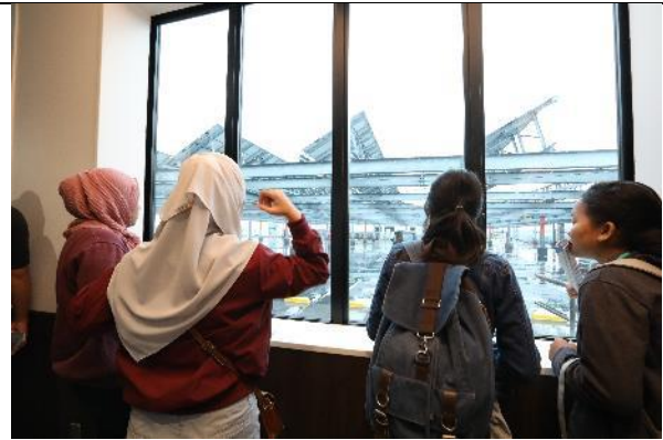
エコストアの屋上駐車場の太陽光発電システム の見学
