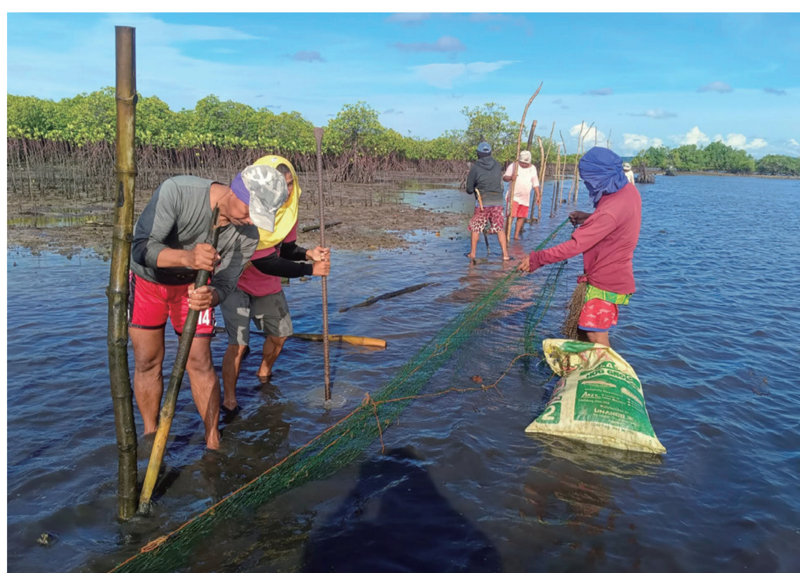
マングローブフェンスの設置
